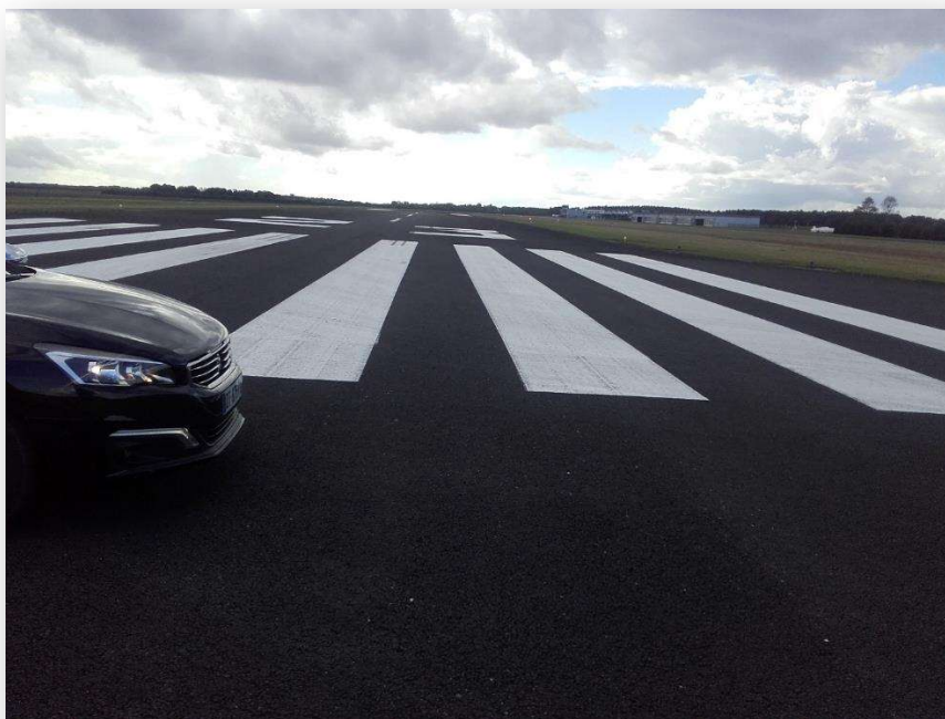
Photo de la piste au seuil 23 – Aéroport du Loiret – Source : Sogeti Ingénierie
